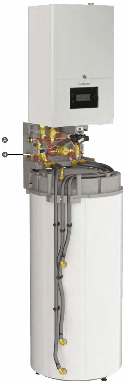
A Vstup studené vody B Výstup TV
